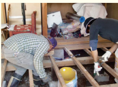
▲床下の泥出し
