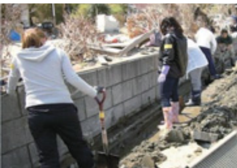
側溝の泥出し（福島県新地町）
